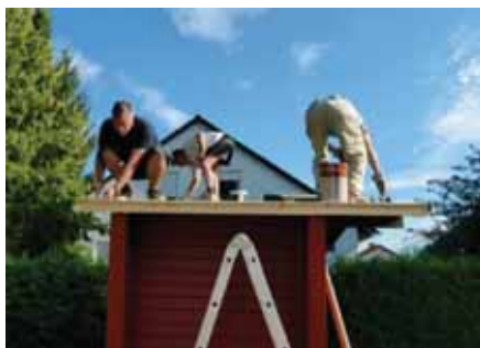
... mit saniertem Dach versehen
