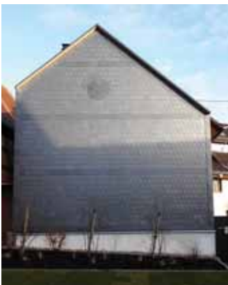
Unten: Die schön mit Schiefer verkleidete Stirnwand des Gebäudes neben dem Wartehäuschen. Davor stand bisher das bereits abgerissene Haus Untergasse 1
